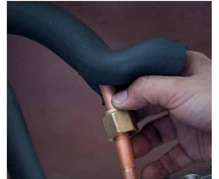
Buhar difüzyon direnci yüksek malzeme ile yalıtılmış boru
